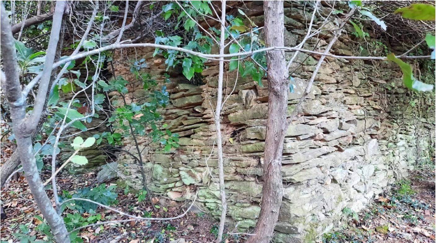
Petit cabanon rectangulaire monté au mortier de terre, d'une surface de 19 m<sup>2</sup>, toiture à 1 pan. Il est situé au bord d'un chemin, et à proximité de la piste Marc Robert.
