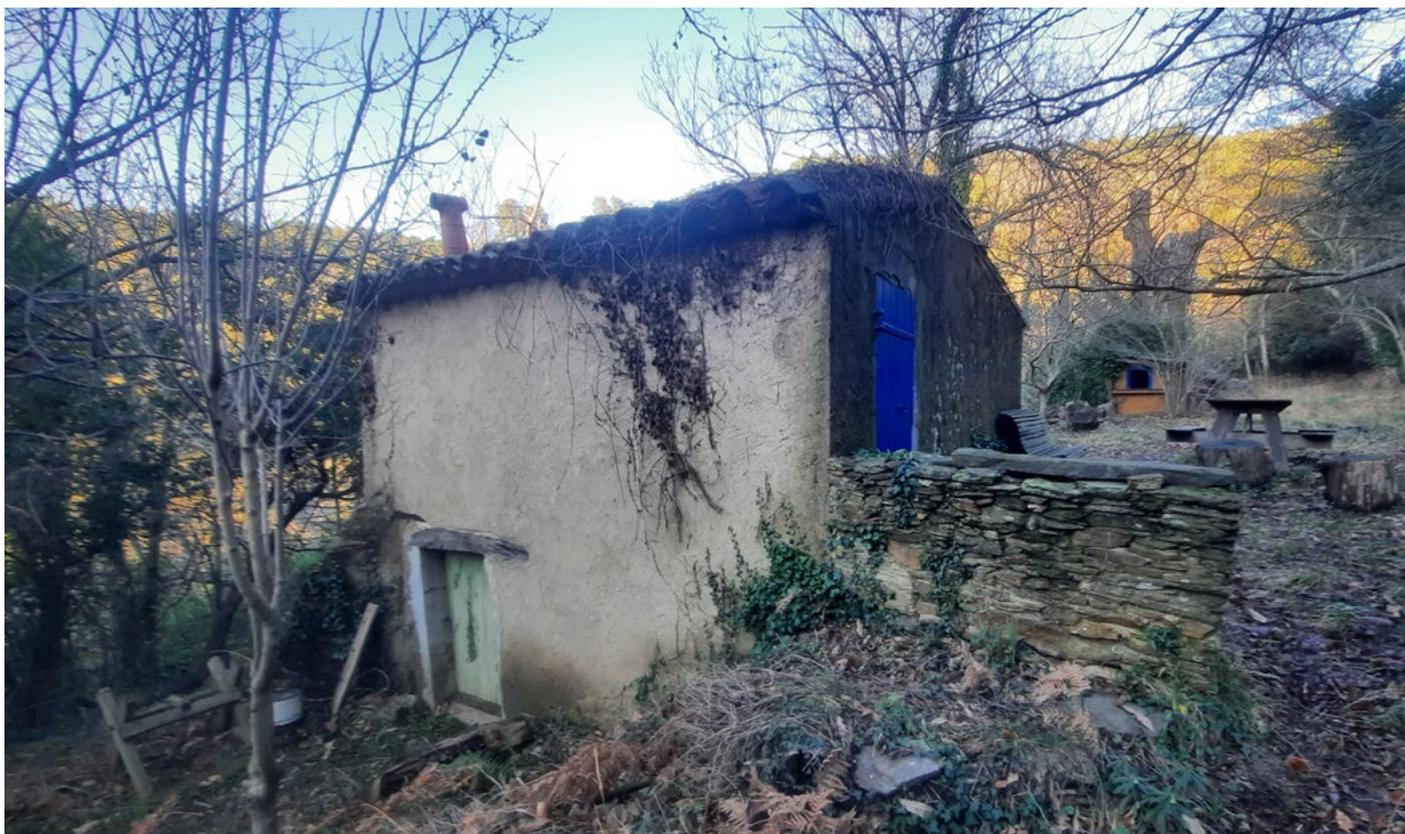
Bastidon de plan carré monté au mortier de chaux ; toiture à 2 pans. 1 porte et 1 fenêtre par niveau. Surface au sol de 23 m<sup>2</sup> hors œuvre, soit 46 m<sup>2</sup>. La porte du soubassement a été réduite.
