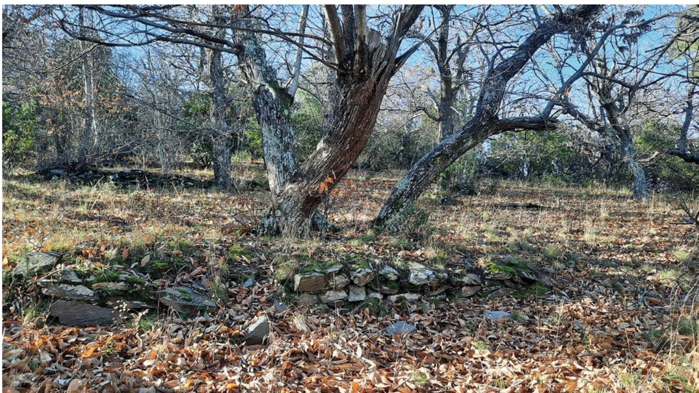
**Restanques de Malvallon (IA83000017, Les Mayons).** 2 petits murs de soutènement de 4,5 m et 4 m de long, pour une hauteur de 0,80 et 0,85 m. Ces 2 murs sont placés chacun au pied d'un châtaignier qui les surplombe et à une distance relativement proche, à environ 1,50 m du tronc.
