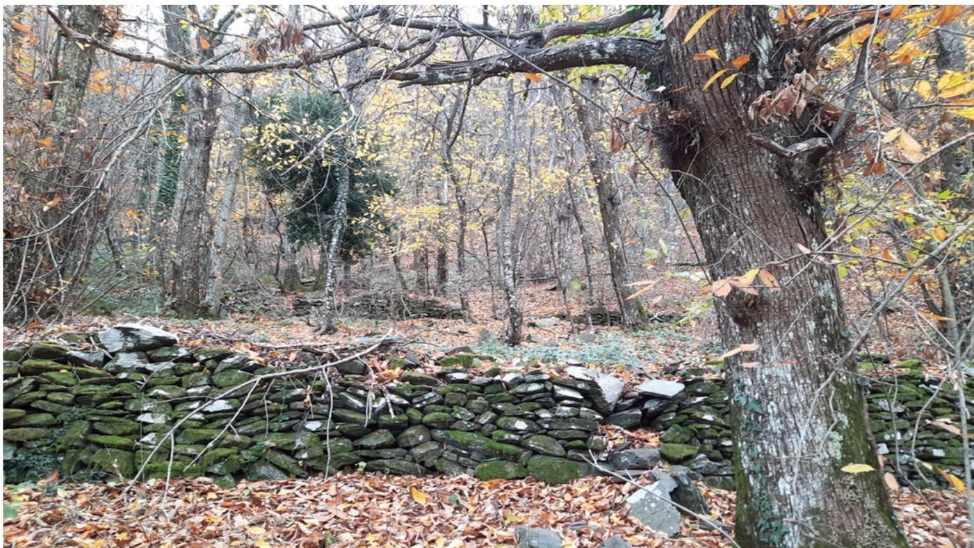
**Restanques de Rouve Gavot (IA83000018, Collobrières).** 2 restanques d'environ 43 m et 53 m de long x 1 m de hauteur quand le mur est bien conservé. Ces 2 murs forment 2 espaces d'environ 14 m de profondeur ; exposition SE. A souligner, le montage du mur « en délit » par endroit (c'est-à-dire que les pierres sont dressées verticalement, ne suivant pas les strates de la pierre ; cette pose rend le mur plus fragile, mais est parfois employée pour améliorer le drainage de l'eau de ruissellement).
