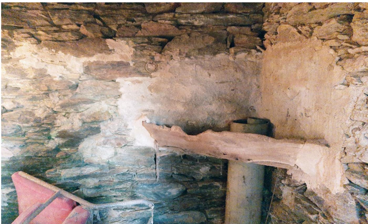
La petite pièce conserve une auge façonnée dans un tronc d'arbre et scellée dans l'angle du mur, ainsi que l'anneau pour attacher l'âne ou la mule.
