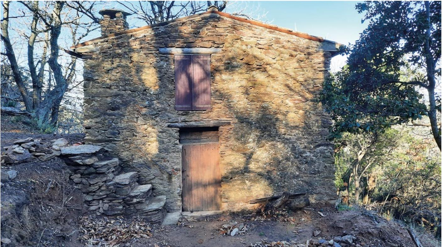
Bastidon de plan pseudo-carré monté au mortier de chaux ; toiture à 2 pans (légèrement exhausé lors de sa restauration). 1 porte et 1 fenêtre par niveau. Surface au sol de 27 m<sup>2</sup> hors œuvre, soit 54 m<sup>2</sup>.
