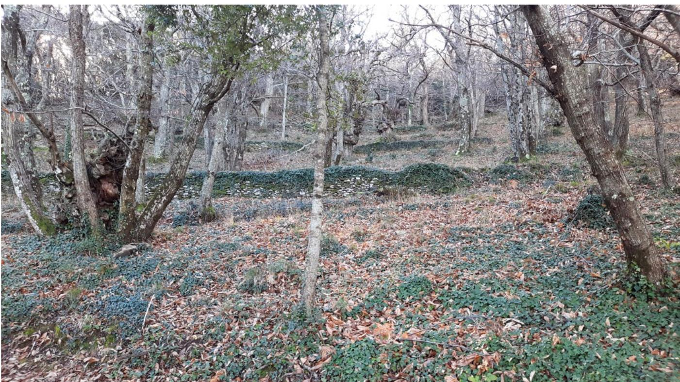
**Restanques des Condamines (IA83000031, Collobrières).** Succession de longs murs de soutènement en pierre sèche. Hauteur des murs d'environ 0,50 à 0,70 m, formant des terrasses de culture de 15 à 20 m de profondeur en moyenne. ; exposition S.
