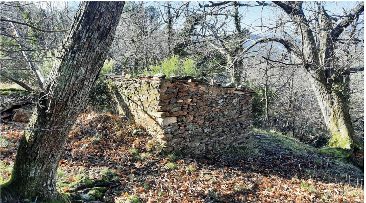
Petit cabanon de plan carré, monté au mortier de chaux, d'une surface de 10,5 m<sup>2</sup>, toiture à 1 pan et tuiles plates. L'ouvrage a été restauré. Il est situé non loin du GR 90, à proximité du carrefour des 4 chemins.
