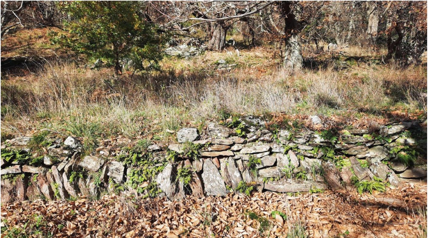
**Restanques de Cancivaou 2 (IA83000027, Les Mayons).** De nombreuses restanques se succèdent, entre 10 et 60 m de longueur et des hauteurs entre 0,80 et 1,20 m. Ces restanques offrent des terrasses de superficies assez grandes, avec des intervalles compris entre 15 et 25 m ; exposition NE.
