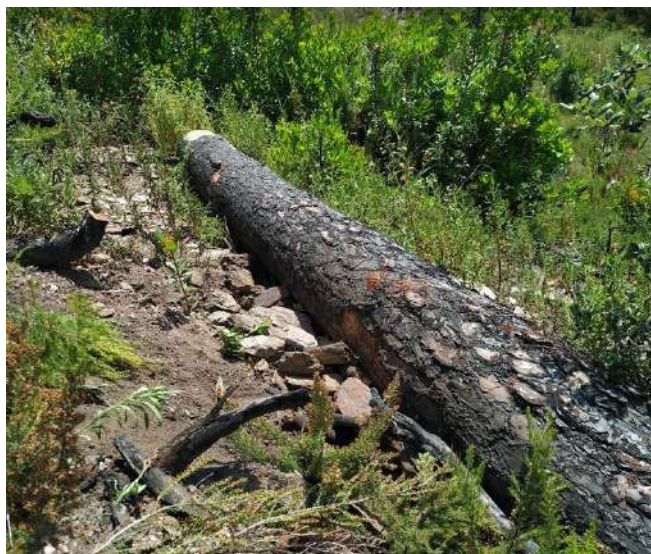
Photos 11 et 12 : Exemples de réalisations sur terrains incendiés à partir des troncs de sujets matures à gauche et de gaules à droite. © Florian Henneau - ASL SV
