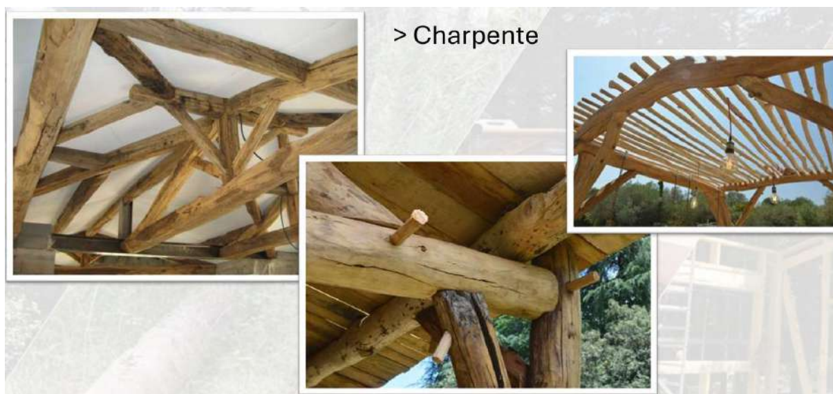
Photos 7 : Charpente en châtaigner. Source : © Permabita
