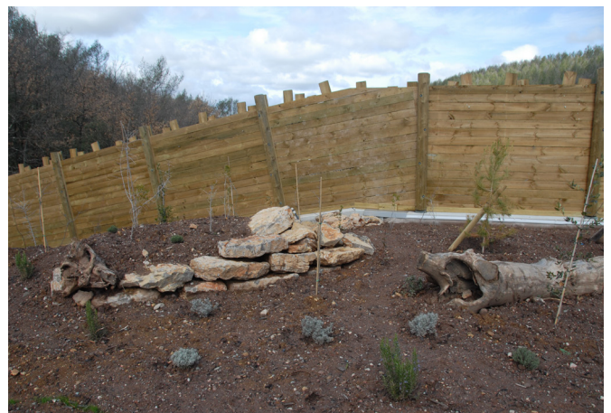
Aménagement "éco-restanque" Vinci-réseau Escota © RASCAS BIODIV
