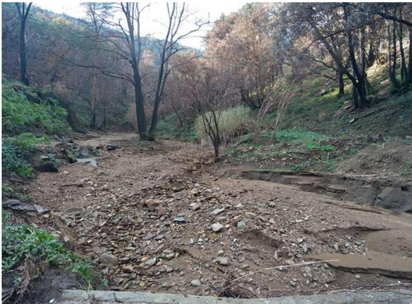
Radier sur le Ruisseau de Val de Gilly – ensablement jusqu’au niveau du radier béton ©Alcina Forêts
