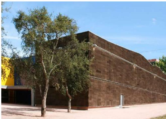
Le liège expansé en panneaux de façade est un matériaux biosourcé d'isolation thermique (hydrofuge, inifuge) ne nécessitant ni enduit, ni bardage ©ecobati.com
